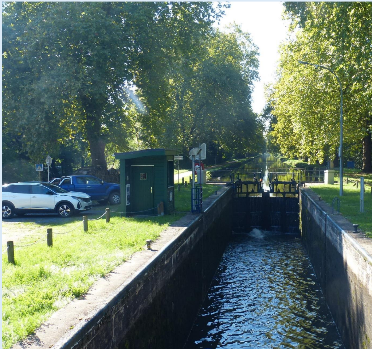
Eine der vielen Schleusen des Canal des Vosges
